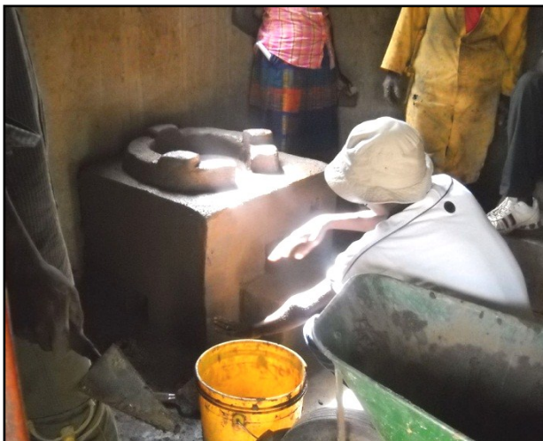
Installatie van een Esperanza fornuis
